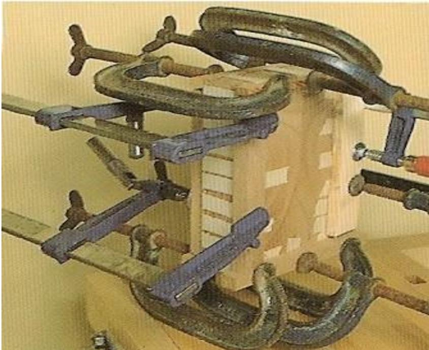
La carcasa tiene cuatro lados con un techo y una base. Se puede sujetar por etapas o en una sola fase con cinta adhesiva para comenzar. Todos los espacios disponibles se sujetan con mordazas "G". Es un ensamble complejo que requiere de una buena preparación de las piezas ya que no se cuenta con mucho tiempo para llevarlo a cabo, por el secado del pegamento.
